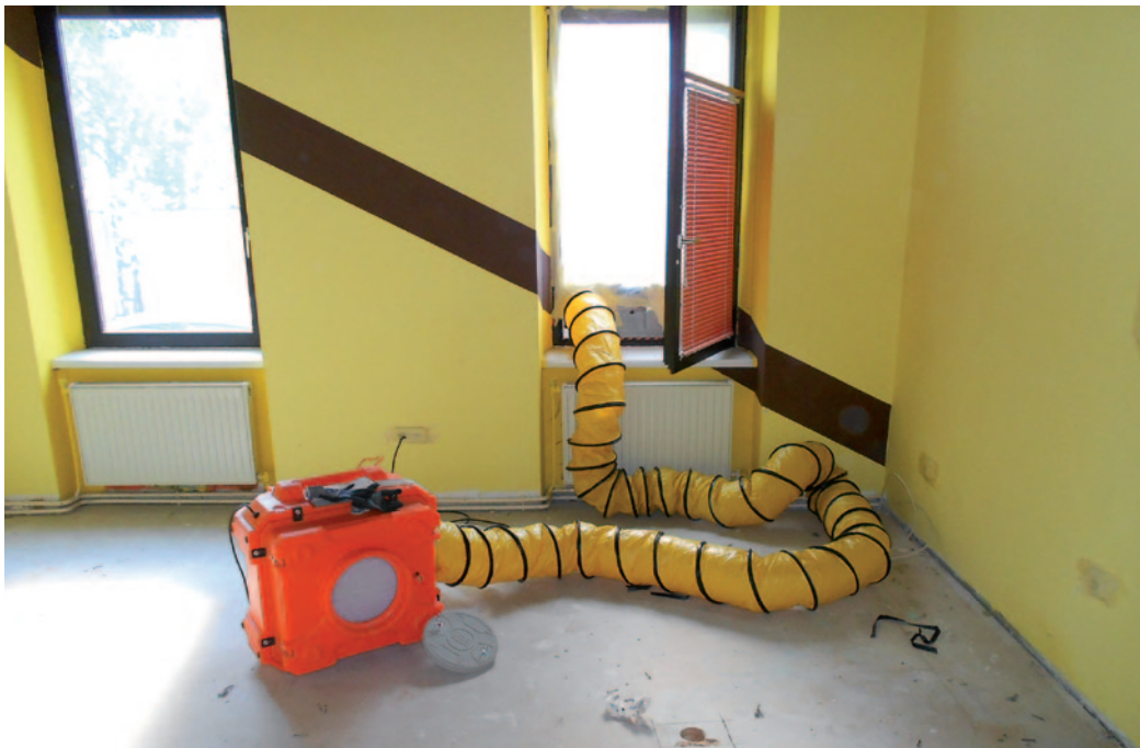
Professionelle Trocknungsmaßnahmen nach Schimmelsanierung
