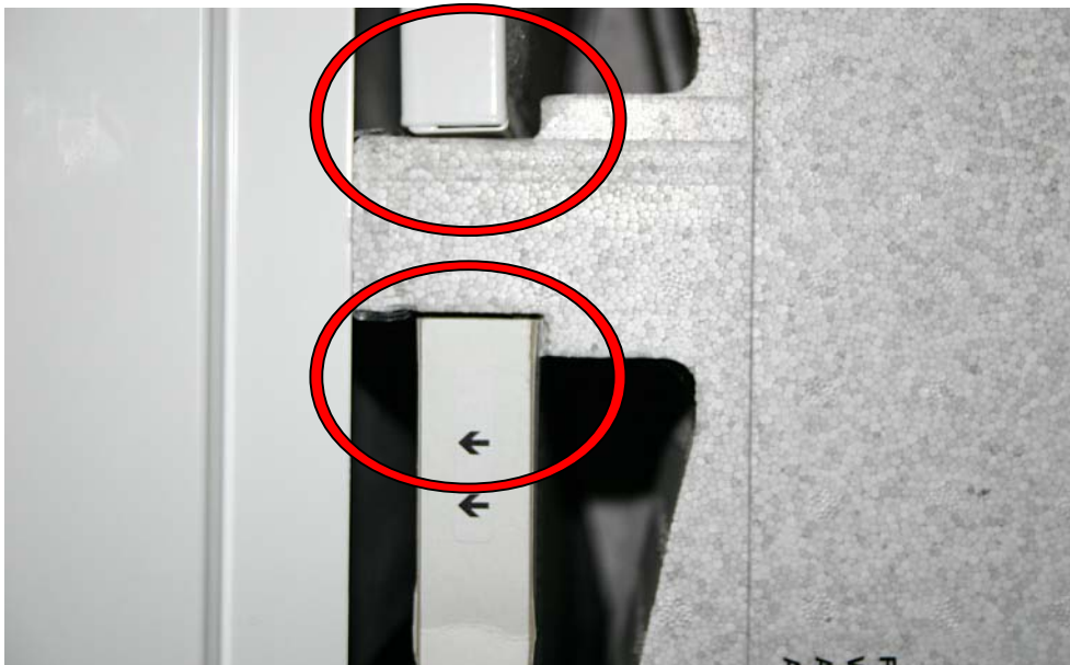
Abbildung 9: Lüftungsgerät mit Außenluftfilter, von Vorderseite betrachtet, Falschluf durch unzureichenden Sitz der Filters (Tappler 2005)
