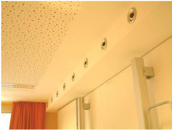
Abbildung 9.23: Düsensabstände etwas zu gering – Abhilfe „Auffächerung“ der Strahlen
