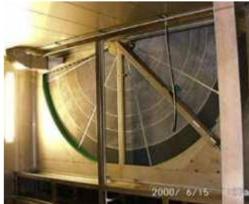
Abbildung 6.25: Rotor mit Sorption – Symbol und Bild
