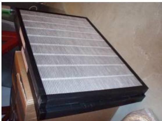
Abbildung 9.41: Kassettenfilter F7 einer zentralen Anlage
