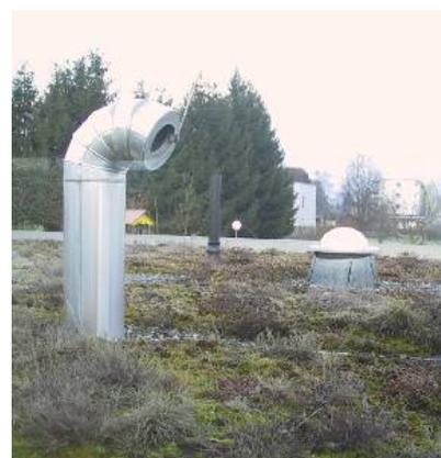
Abbildung 9.39: Fortluftführung über Dach
