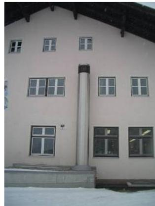
Abbildung 9.26: Eine sehr großzügig ausgeführte Ansaugung einer zentralen Lüftungsanlage mit Erdwärmetauscher
