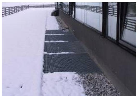
Abbildung 9.31 a und b: Ansaugsituation durch Kellerschacht: li Blick in den Schacht, re. Außenansicht: Gefahr der Ansaugung von bodennahen Gasen (z.B. Radon). Schneefreiheit durch Fassaden-
