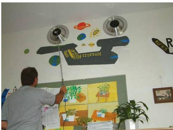
Abbildung 9.24: Überdimensionierung der Kugeldüsen (DM 150, Austrittsgeschw. 3,5 und 3,9 m/s)
