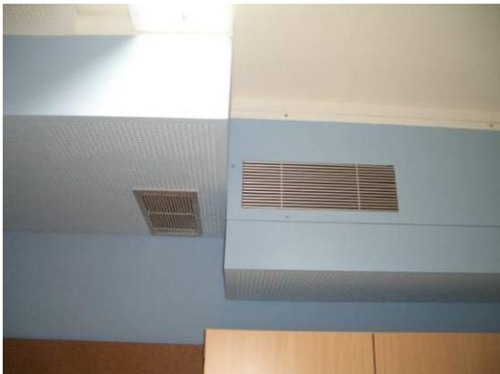
Abbildung 9.8: Luftführung Zu- und Abluft
