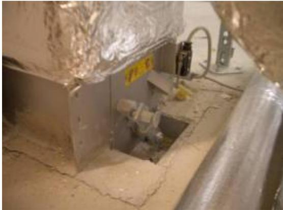
Abbildung 9.58: Brandschutzklappe mit Kontaktschalter für GLT
