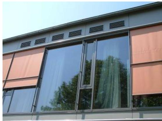
Abbildung 9.28: Ansaugung über Gitter in der Drenpelwand des Spitzbodens
