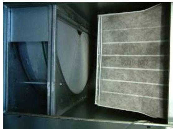
Abbildung 9.42: Quer Stehende Taschenfilter einer zentralen Anlage
