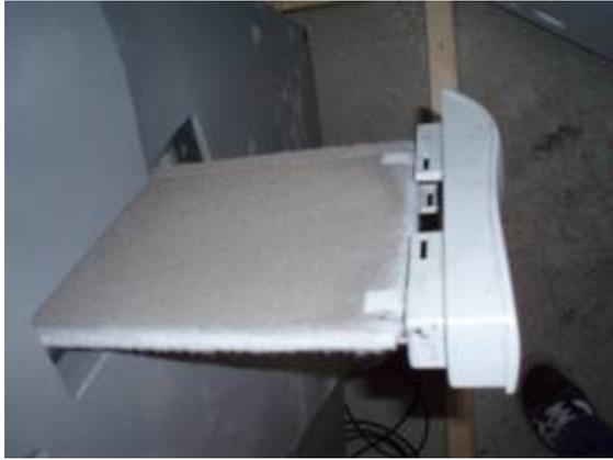
Abbildung 9.43: Einfache Filtermatte (G4) einer dezentralen Anlage
