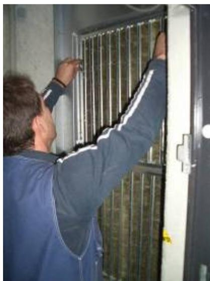
Abbildung 9.37: Großzügig dimensionierter, vor Durchfeuchtung geschützter Filter (F6) vor dem gemauerten (begehbaren) EWT entlang eines unterirdischen Verbindungsganges zwischen zwei Gebäuden
