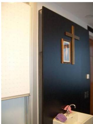
Abbildung 9.60: Verdeckt ausgeführter Überströmbereich
