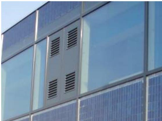
Abbildung 9.32: Außenluftansaugung und Fortluftauslass sind weniger als 2 m voneinander getrennt
