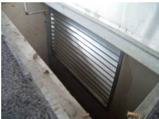
Abbildung 9.38: Fortluft über einen Kellerschacht
