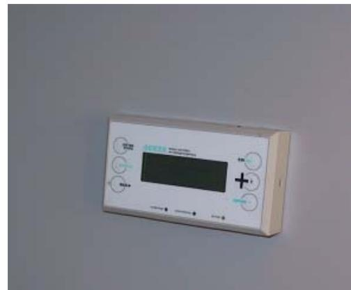
Abbildung 9.47 a und b: Steuerungsgeräte für dezentrale Lüftungsgeräte
