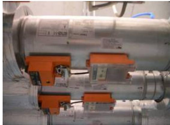
Abbildung 9.49 a und b: Automatische Luftmengenregelung über Mischgasfühler
