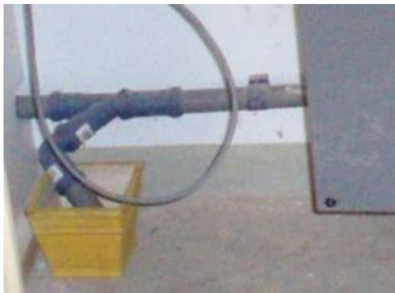
Abbildung 9.46: Provisorische Lösung für das Kondensat (mit Leckströmung)
