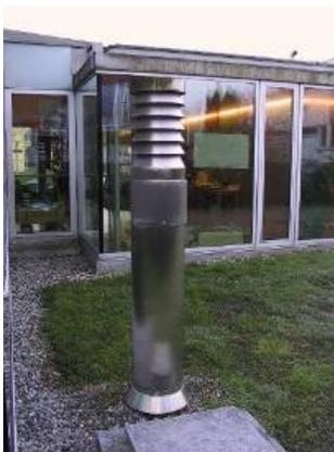
Abbildung 9.27: Ansaugung einer dezentralen Anlage
