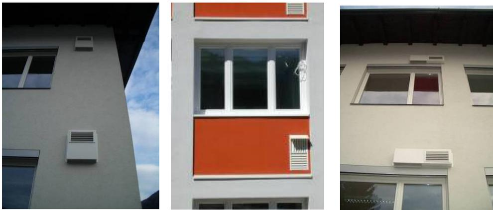
Abbildung 9.35 a–c: Speziell ausgeführte Außenluftansaugung/Fortluftauslass
