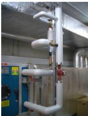
Abbildung 9.52: Nacherwärmung über ein wassergeführtes System
