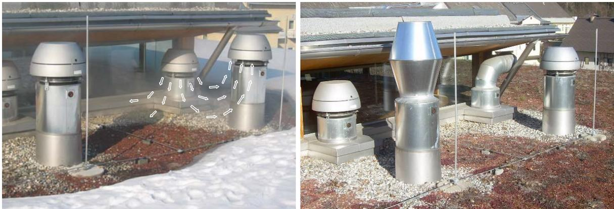
Abbildung 9.33: „Kurzschluss“ zwischen Ab- und Zuluft beim Kaltrauchtest (Quelle: Heiduk, 2008)
